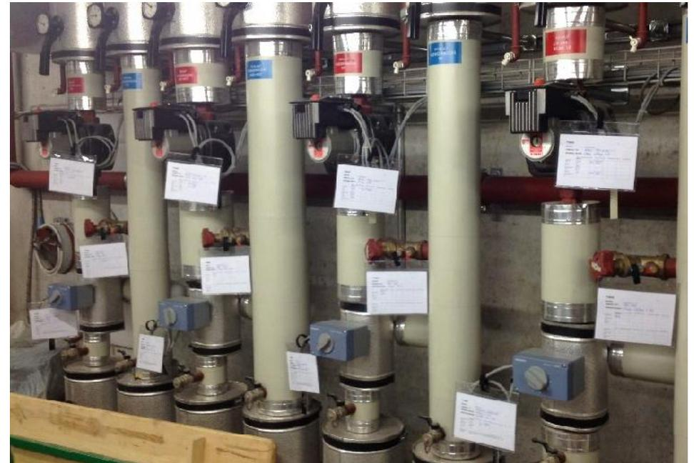
Beispiel eines Heizungsverteilers, mit beschrifteten Anlagekomponenten
