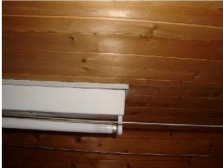
Asbesthaltige Leichtbauplatte als Brandschutz unter Leuchtstoffröhre
