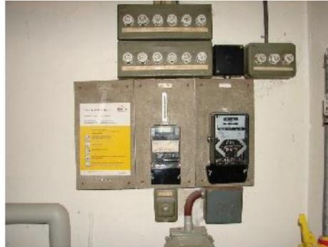
Asbestzementplatten als Montageplatten für Elektrotabelleaus
