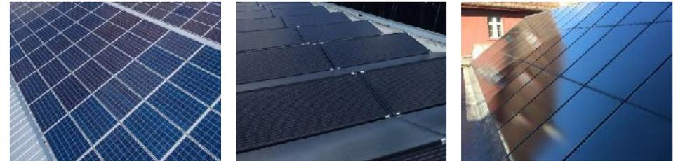
Polykristallin [Solvatec AG] Monokristallin [Solvatec AG] Dünnschicht [Solvatec AG]
