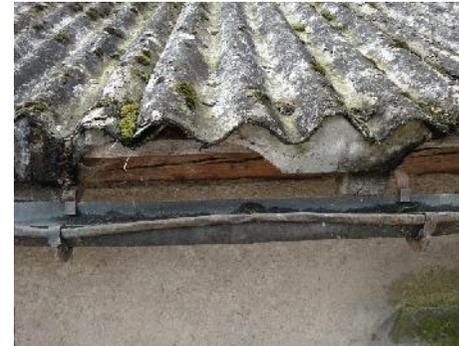
Stark verwittertes Asbestzementdach
