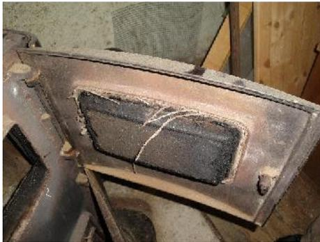
Asbestschnur als Dichtung in einer Ofentür
